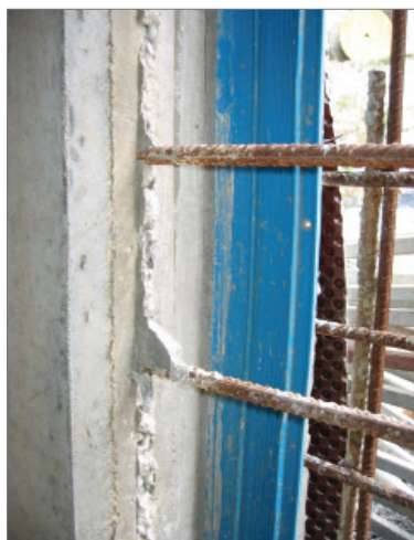
Fig. 1. Junta de dilatación interior
